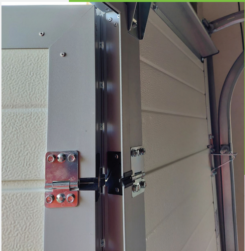
Dovršeni detajl osebnega prehoda.
